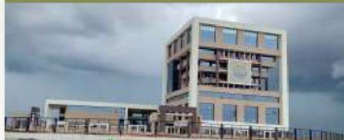
ABCD BUILDING ACTUAL VIEW
