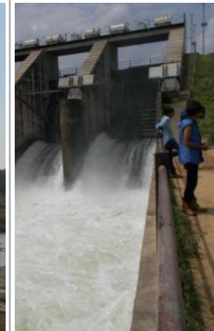
Narmada Main Canal
